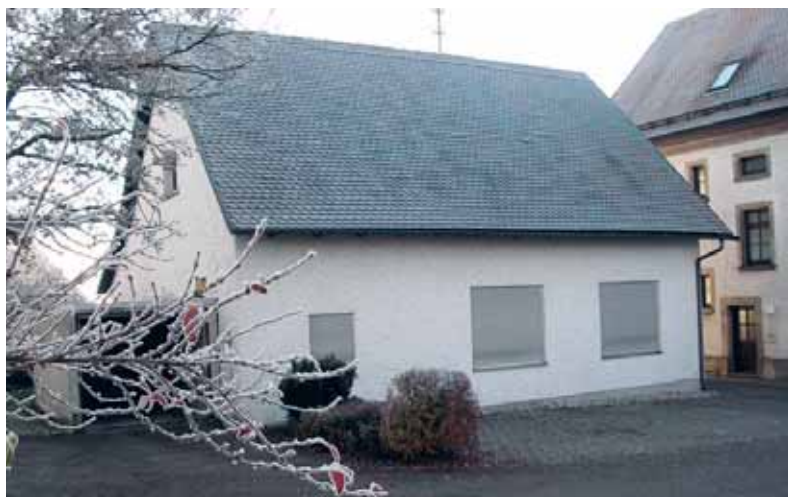
Das Josefshaus diente bislang als Gemeindehaus und wird abgerissen.
